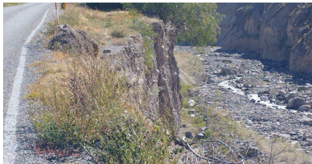
vista aguas arriba tramo medio, se observa talud socavado y trocha en peligro inminente
